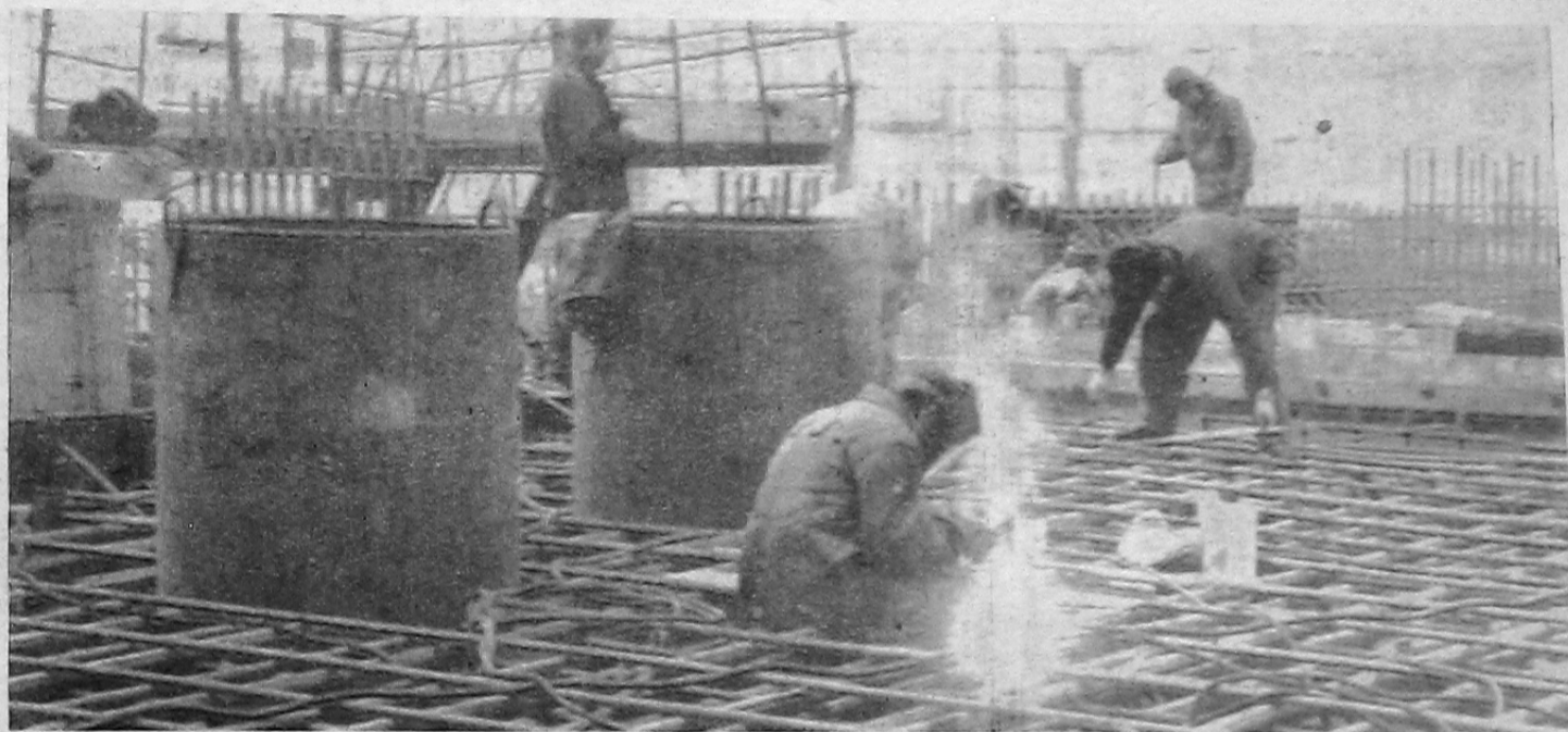
Правый берег. Идет подготовка к укладке бетона.
