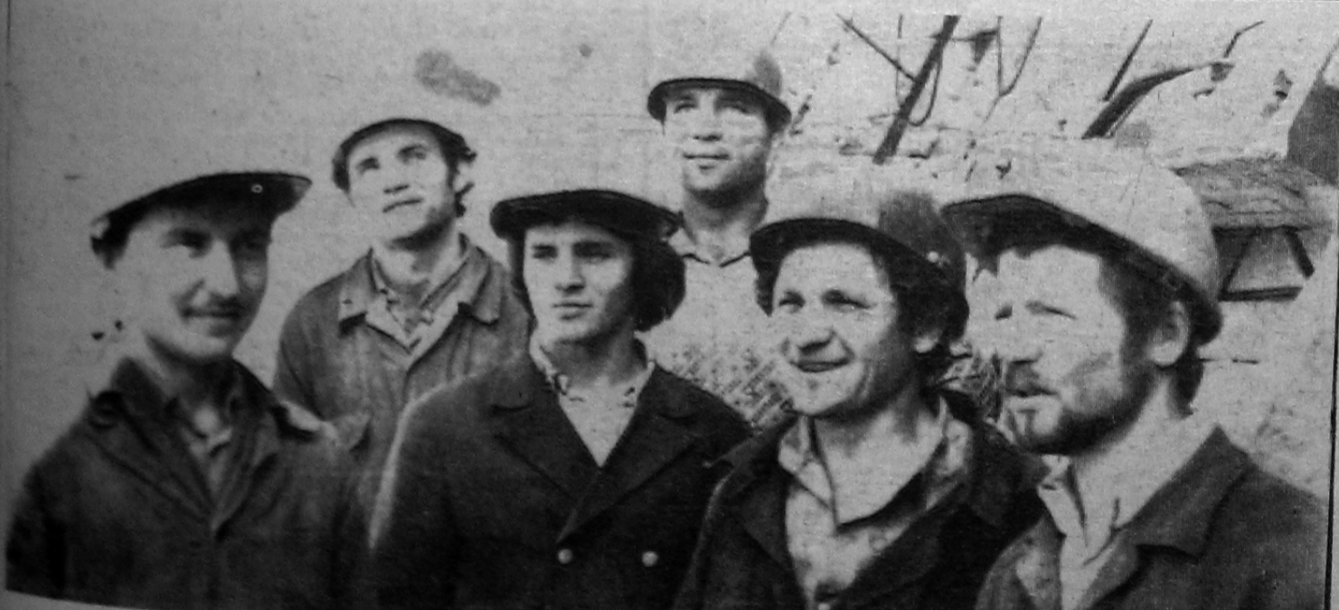
На снимке: передовые строители из бригады плотников-бетонщиков М. Машенко — Николай Резниченко, Алексей Полященко, Гинадий Бачков, Николай
