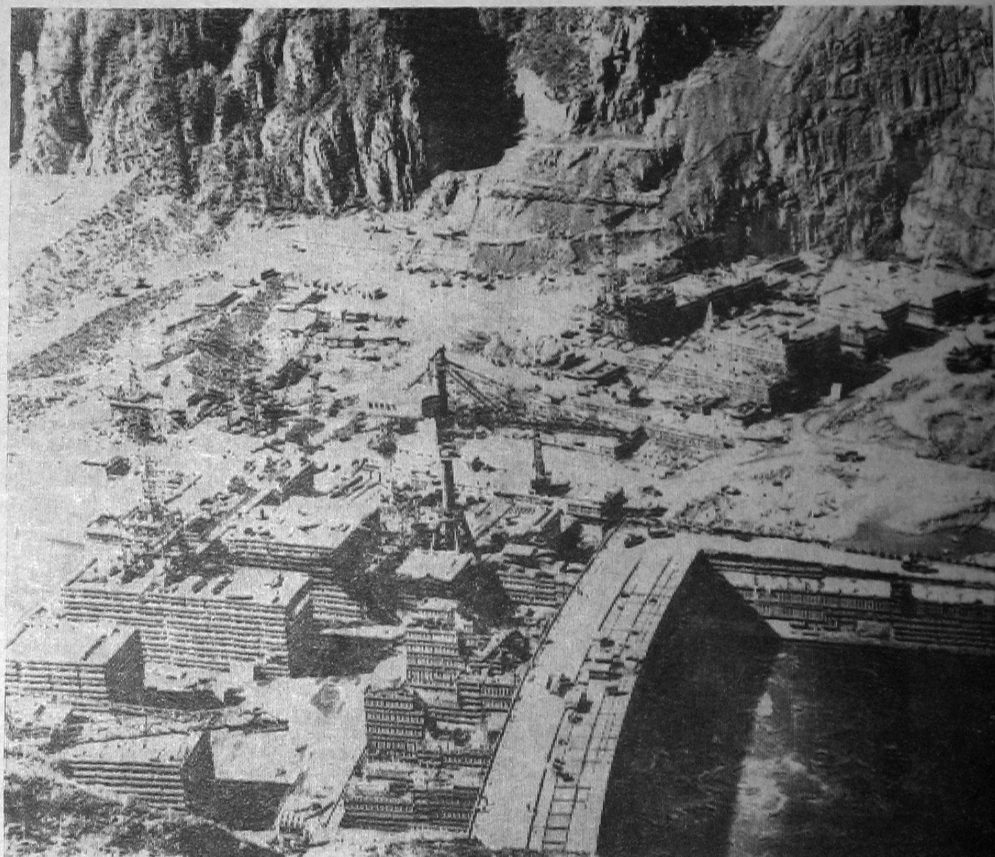
КАРЛОВСКИЙ СТОРОМ. ЗДЕСЬ ВОЗВОДИТСЯ САЯНО-ШУШЕНСКАЯ ГЭС. Фото Г. КАНУНИКОВА.
