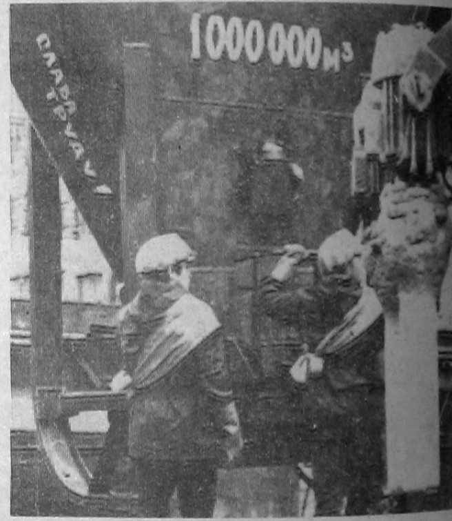
31 августа 1976 г. был уложен миллионный кубометр бетона в плотину Саяно-Шушенской ГЭС.
