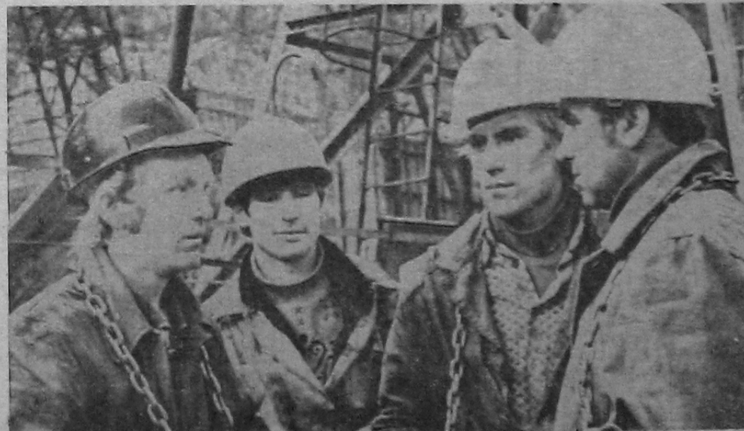
В решающие дни подготовки к штурму Енисея весомый вклад в трудовые успехи гидростроителей вносит бригада Героя Социалистического Труда А. Алеева. На снимке: монтажники передового коллектива. Фото Р. МАНЯФОВА.
