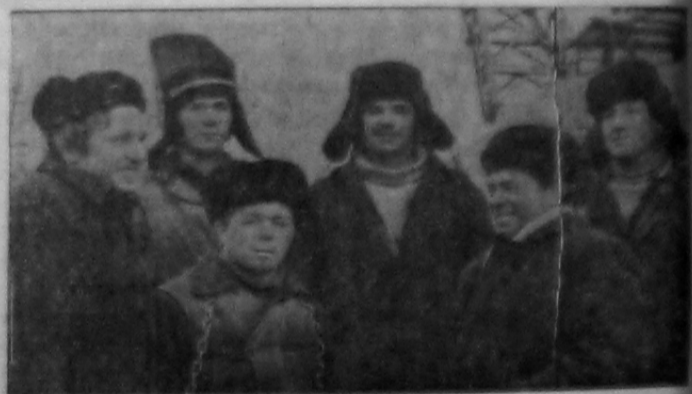
Бригада плотников-бетонщиков УОС, которую возглавляет Вилиям Черков, — одна из правофланговых соревнований в честь XXV съезда КПСС. Она успешно выполняет задания по укладке бетона.
