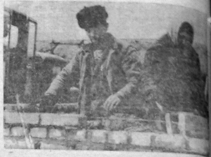
ного завода; бригадир каменщиков СМУ-1 Михаил Семченко и Валентина Семченко. Идет кирпичная кладка на щитовом распределительном устройстве. В день коммунистического субботника бригада добилась высокой производительности труда. Фото Г. КАПУШНИКОВА.
