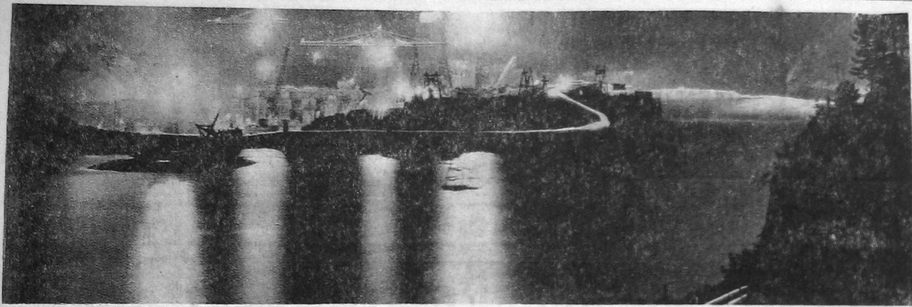
СТРОИТЕЛЬСТВО САЯНО-ШУШЕНСКОЙ ГЭС: КОТЛОВАН ПРАВОГО БЕРЕГА НОЧЬЮ. Фото Р. МАНЬФОВА.
