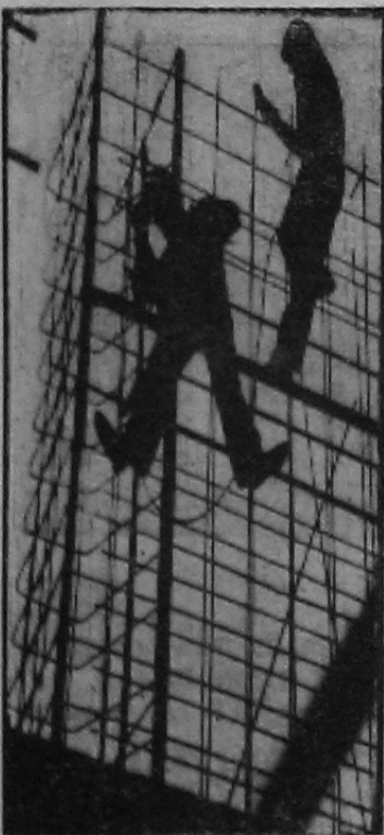
● Арматурщики «плетут» металлические кружева.
