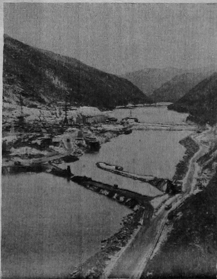
В НЕБЫВАЛО КОРОТКИЙ СРОК ГИДРОСТРОИТЕЛИ ВЫПОЛНИЛИ РАБОТЫ ПО СОЗДАНИЮ ЛЕВОБЕРЕЖНОГО КОТЛОВАНА.
