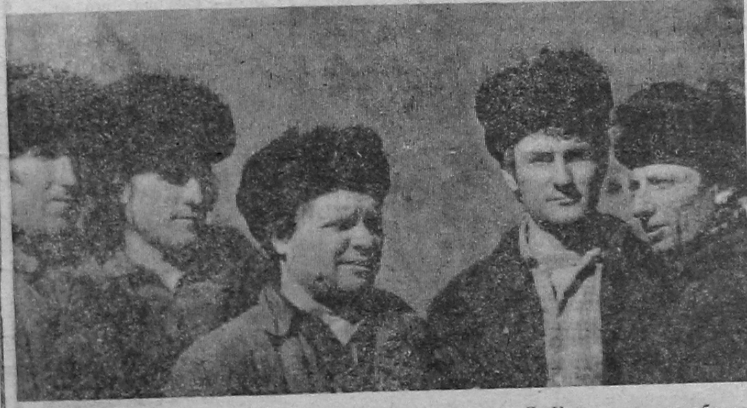
Передний край бригады бурльщиков Гидроспецстроя Д. Калачева - левобережная врезка плотины ГЭС. На 180 процентов коллектив выполнил задание марга. Каждый трудовой день рабочие встречают по-ударному. На снимке: бурльщики Ю. А. Непомнящих, М. М. Шаров, Н. С. Лобазов, Г. П. Зыков и Д. Ф. Калачев (бригадир).
