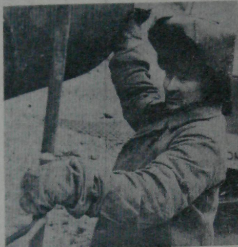
Бригада арматурщиков В. В. Полищукова вносит весомый вклад в широкое развертывание работ по укладке бетона в котловане.
