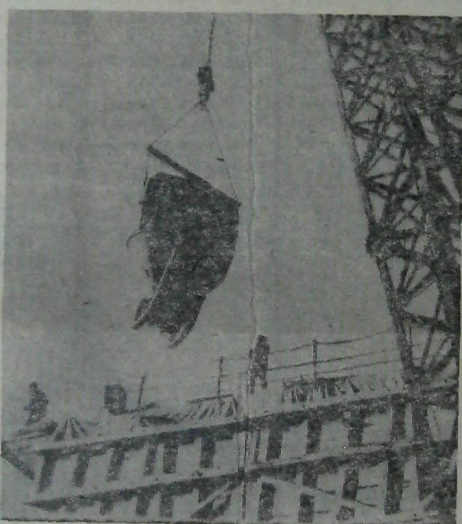
В ПРАВОБЕРЕЖНОМ КОТЛОВАНЕ
