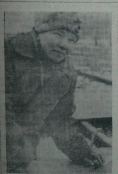
Профессия слесаря-монтажника — одна из трудных и важных. С честью справляется со своими обязанностями Рафига Фаизуллина (Гидромонтаж).
