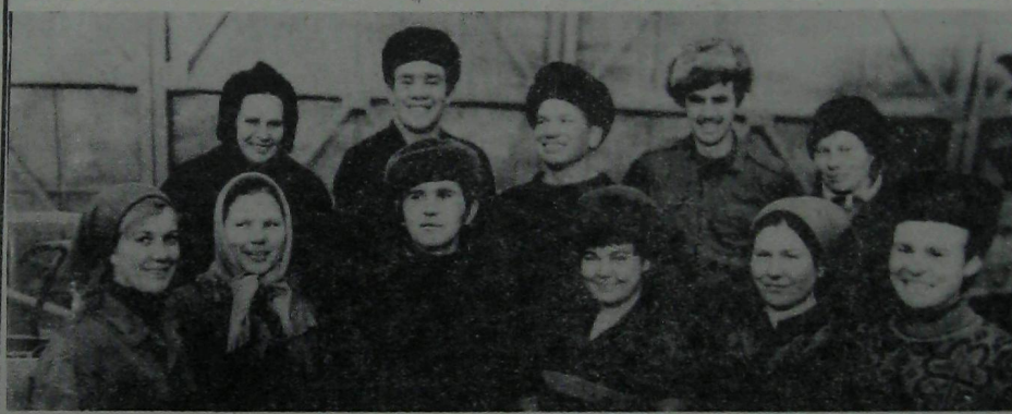
НА СНИМКЕ: бригада бетонщиков второго формовочного цеха: О. Коровяков, Н. Тропин, Б. Чигаев, В. Коровяков, В. Юрьев, Л. Верстюк, Г. Гимберг, В. Кононова, М. Золотых, М. Хотенко, В. Персиянцева.
