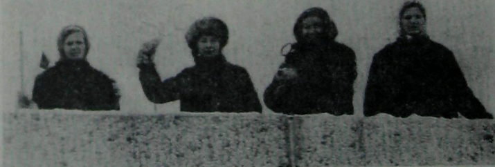
В этом году должен вступить в строй торговый центр в поселке Черемушки. На объекте заняты в основном строители второго строительно-монтажного управления. Бригада каменщиков Ф. В. Четвертака ведет кирпичную кладку. Хорошо трудится здесь бригада изоляровщиков, которую возглавляет Елдокия Степановна Чернова.
