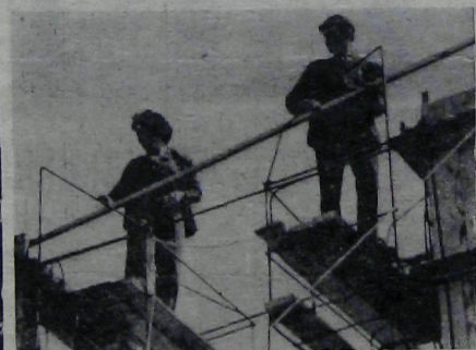
Строительство гравийно-сортировочного завода.
