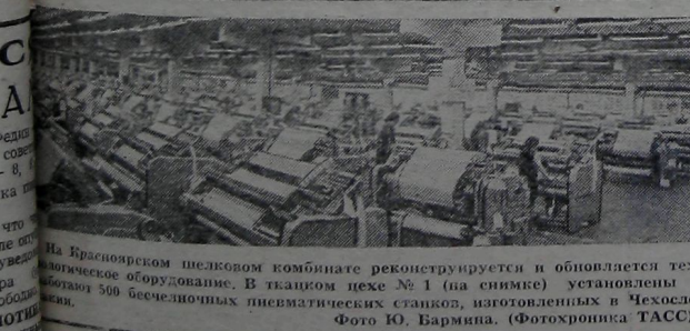
На Красноярском шелковом комбинате реконструируется и обновляется технологическое оборудование. В ткацком цехе № 1 (на снимке) установлены и введены в эксплуатацию 500 бесшумных пневматических станков, изготовленных в Чехословакии. Фото Ю. Бармина. (Фотохроника ТАСС).
