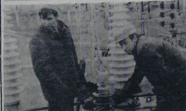
Во время субботника одна из бригад Гидроэлектромонтажа продолжала работу по реконструкции ГПП-1. На снимке: бригадир К. Дорогов и монтажник А. Нойчик делают обвязку газовой системы.
