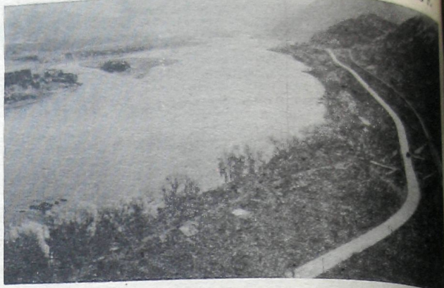
Рядом с Енисеем идет бетонная трасса к Карловскому створу.
