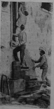
На снимке: ремонт здания фабрики. Фото С. Афонина. (Фотохроника ТАСС).
