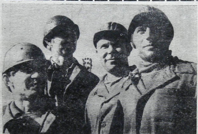
Бригада Н. Д. Рогозы — одна из лучших в прорабстве Гидромонтажа, Ее главный объект — строительство первоочередного бетонного завода.
