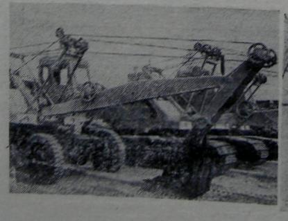
Коллектив Калининского экскаваторного завода — передовой средой предприятий Министерства строительного, дорожного и коммунального машиностроения СССР. В мае здесь начато серийное производство модернизированных экскаваторов. Они более надежны в эксплуатации, имеют увеличенный объем ковшей, для машиниста оборудована удобная кабина.
