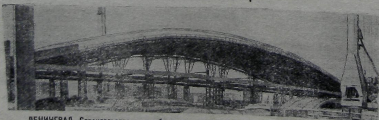
ЛЕНИНГРАД. Строительство автобусного парка начал трест № 16 «Главленинградстрой». Площадь нового парка превысит 15 тысяч квадратных метров. В нем смогут разместиться 500 автобусов. Фото М. БЛОХИНА.
