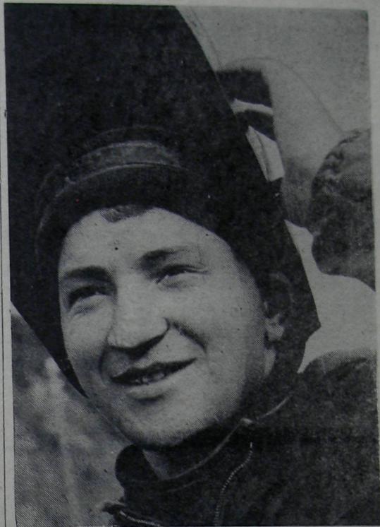
Заслуженным авторитетом в коллективе строительно-монтажного управления №2 пользуется монтажник комсомолец Николай Путищев, работающий в бригаде тов. Огнева. Хорошую работу он сочетает с учебой в техникуме.
