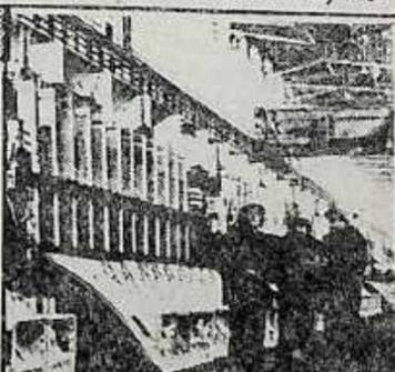
мощностью 6,4 млн. кВт с бетонной арочно-гравитационной плотинной высотой 245 метров и длиной 105,7 м, в соответствии с нормативными требованиями профилактиковосстановительных работ.
